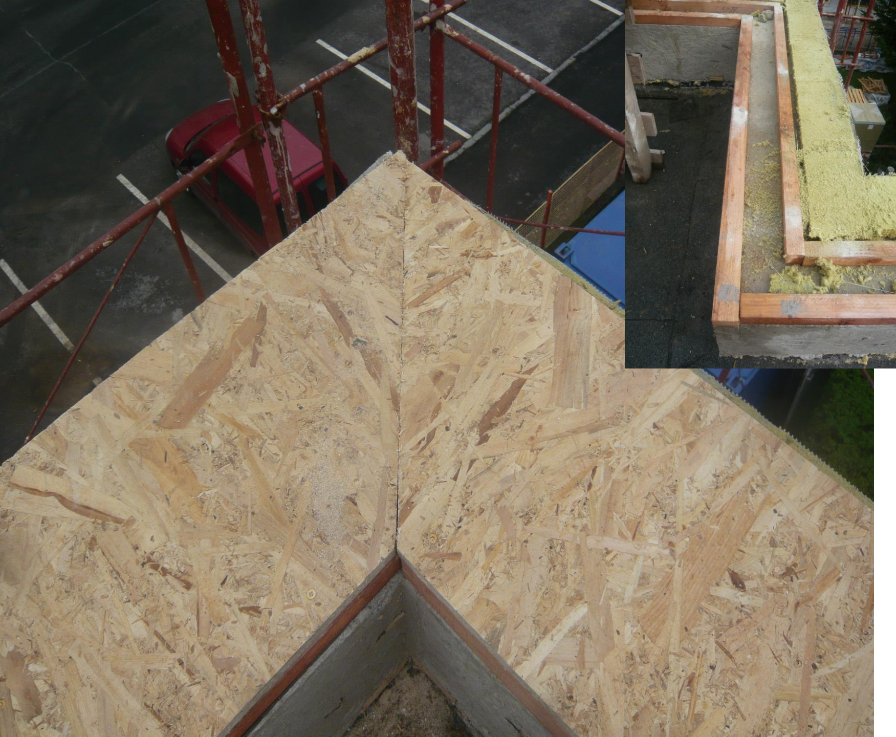
Obnova atiky strechy objektu
