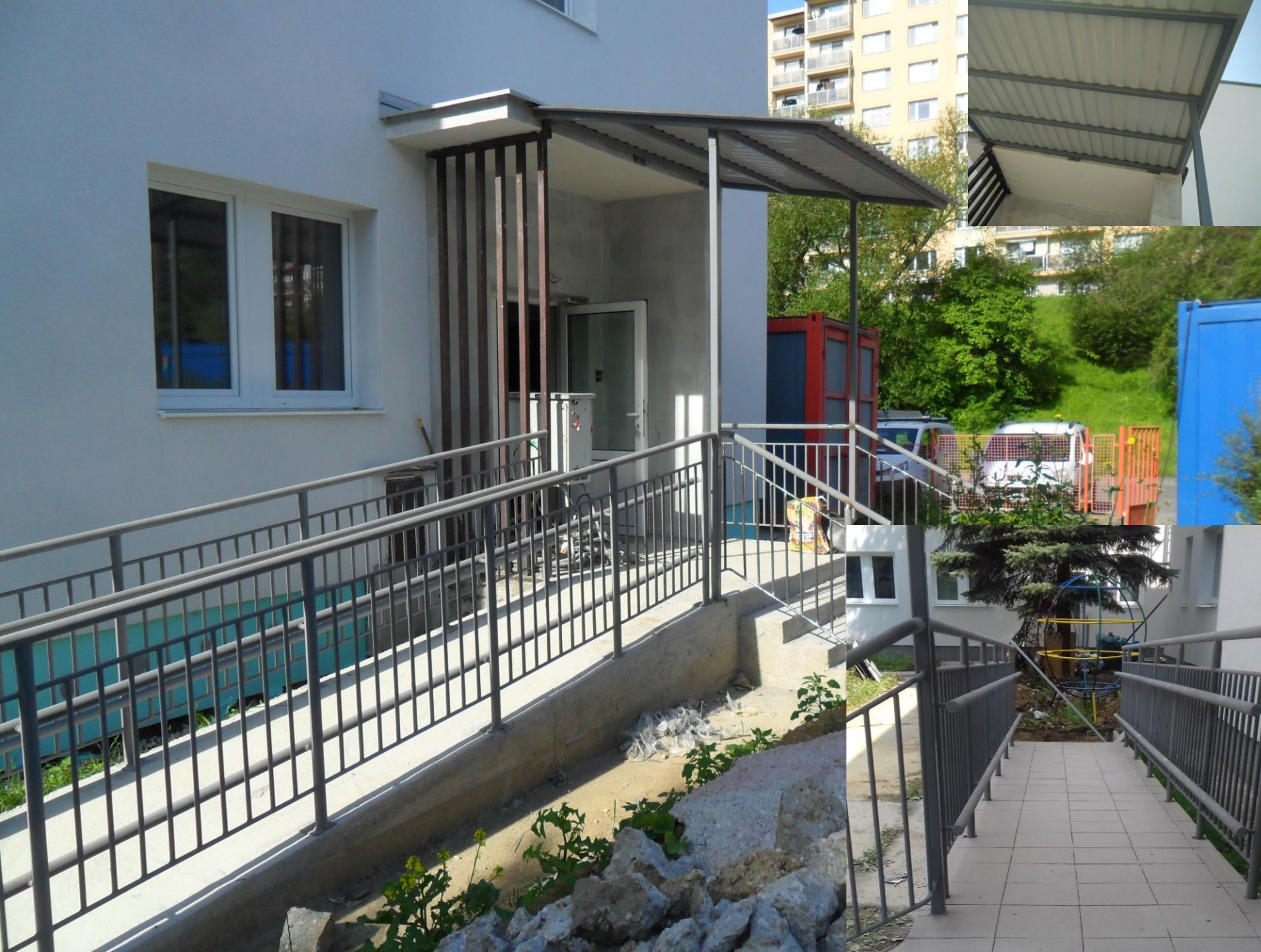
Výstavba bezbariérového vstupu
