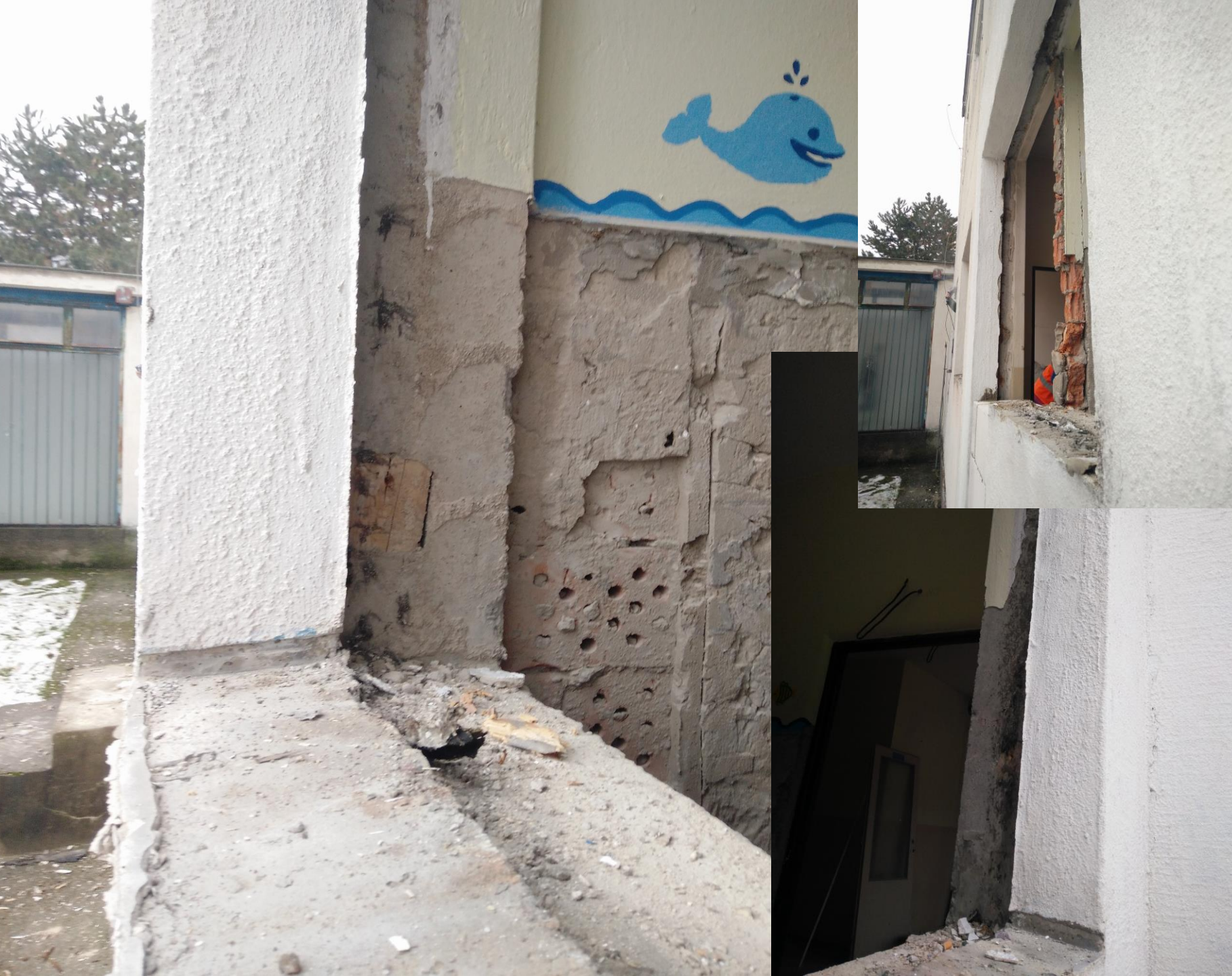
Demontáž starých okien
