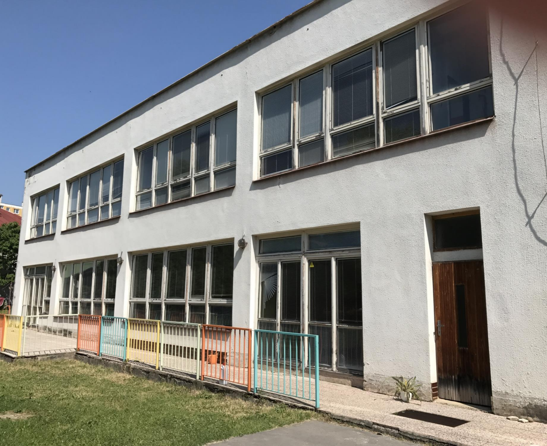
Materská škola Na Lúčkach 2, Banská Bystrica
